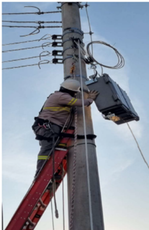
Figura 7 – Foto Treinamento de instalação em campo do conjunto BTMI
